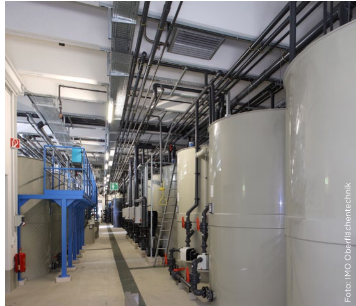
Modernste Abwasser- und Lufttechnik sorgen u. a. dafür, dass in jeder der Hallen sechs bis sieben Mal pro Stunde die Luft ausgewechselt wird.
